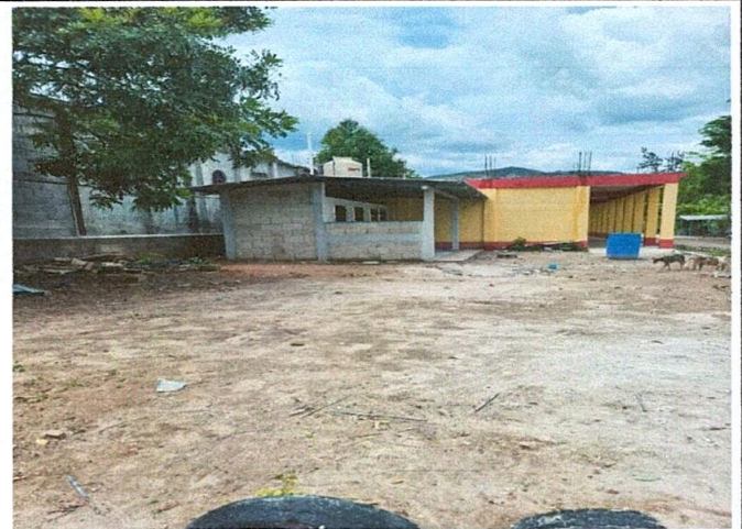
Foto 2: Área de mejoramiento de sanitarios e instalación de estructura tipo pórtico, estación de lavado de manos.
