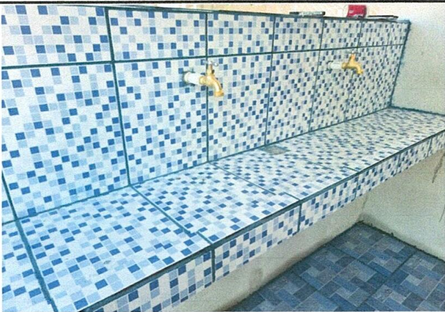
Foto 3: Mejoramiento de área de lavado de manos
