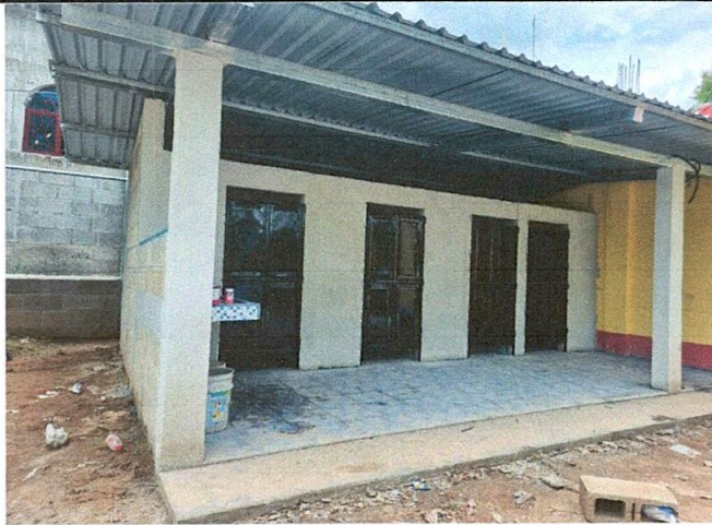
Foto1: Mejoramiento de los servicios sanitarios
